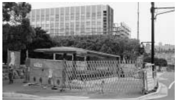
現在工事中の「名古屋大学」駅出入口
