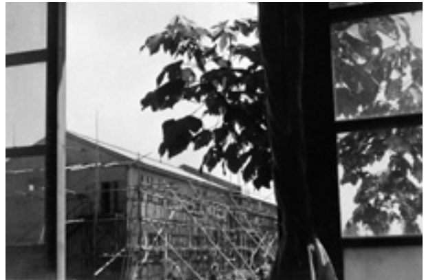
建設中の農学部1・2号館(安城)
