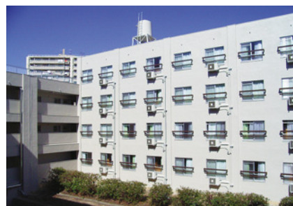
B棟南側外観（改修後）
